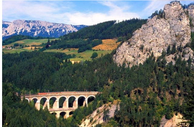
Viadukt „Kalte Rinne“
